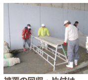
被覆の回収・片付け
